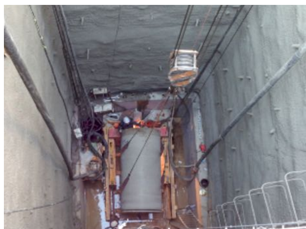
Fig. 20 Jacking pipe coborâtă în baza de lucru
