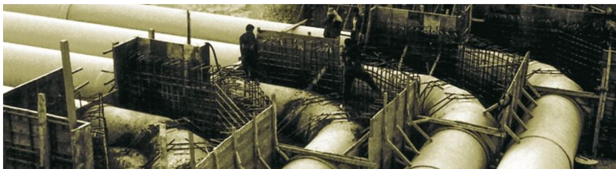
Fig. 41 Conducte îmbinate cu deviere unghiulară
