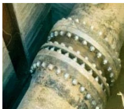
Fig. 30 b) Flanșe montate pe conducte
