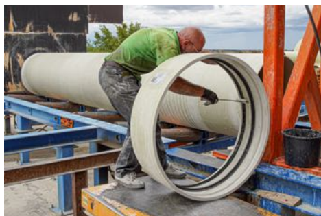
Fig. 25 b) Mufă Reka în pregătire pentru montaj la capătul unei conducte din GRP/PAFSIN
