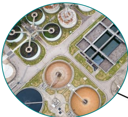
stații de tratare a apei potabile
