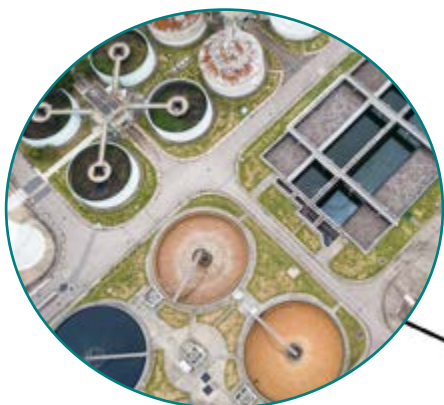
stații de tratare a apei potabile
