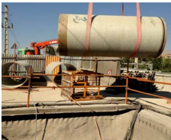
Fig. 19 Jacking pipe pregătită pentru instalare
