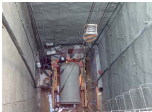
Fig. 20 Jacking pipe coborâtă în baza de lucru
