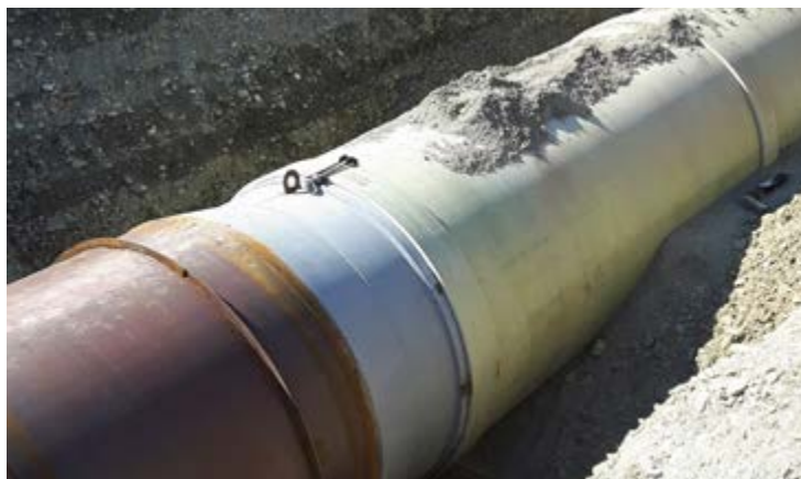
Fig. 28 Piesă metalică specială de îmbinare tuburi de oțel cu tuburi GRP/PAFSIN
