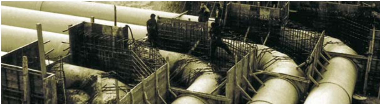
Fig. 41 Conducte îmbinate cu deviere unghiulară
