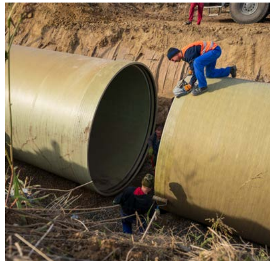
Fig. 3.2: Instalarea subterană standard a unui sistem de conducte uniaxiale de GRP/PAFSIN DN 2800
