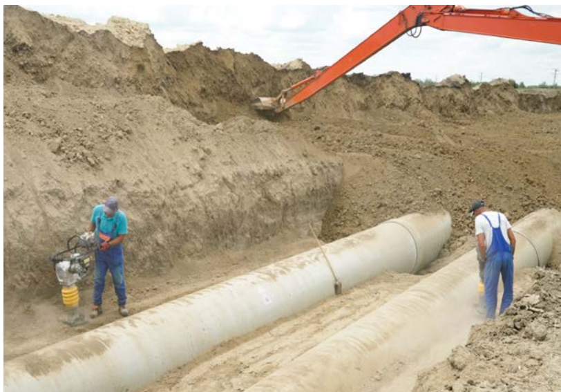
Fig. 3.13 Compactare folosind o placă vibratoare
