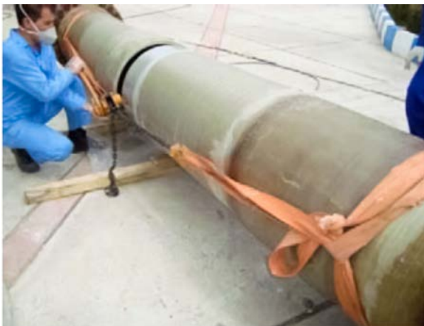
Fig. 4.26 Mufarea cu ajutorul tirforului
