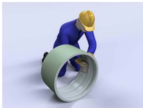
Fig. 4.10 Curățarea nișelor înainte de montarea garniturii
