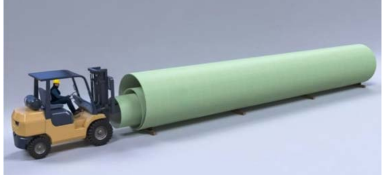
Fig. 2.7 Descărcarea corectă a conductelor din interior, în cazul transportului conductă-în-conductă
