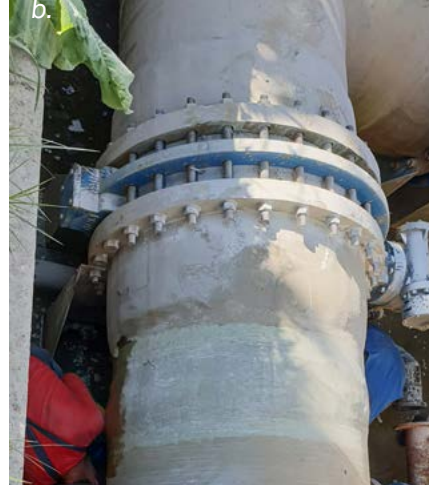
Fig. 4.21 a. Flanșe din PAFSIN, b. Conducte îmbinate cu flanșe din PAFSIN
