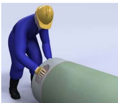
Fig. 4.6 Curățirea capetelor de îmbinare ale conductelor
