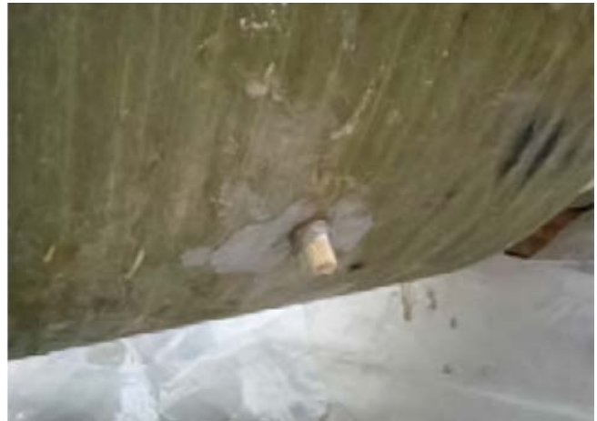
Fig. 4.28 Astupați gaura după injectarea adezivului
