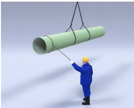
Fig. 2.5 Descărcarea individuală a unei conducte folosind o sfoară de ghidaj
