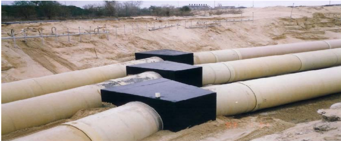
b. Schiță masive de ancoraj pentru cot
