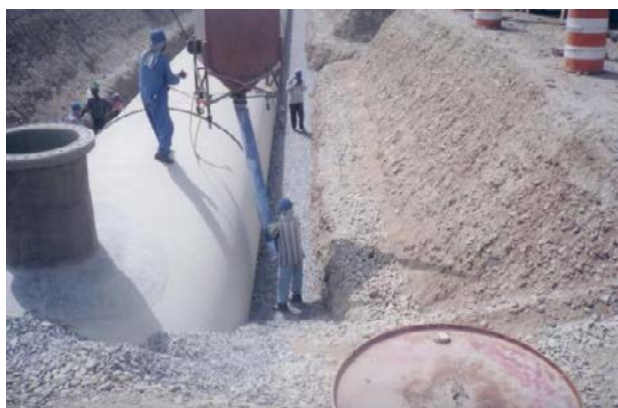
Fig. 3.10 Executarea umpluturilor pentru instalarea conductelor din PAFSIN îngropate
