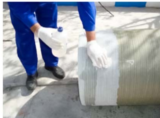
Fig. 4.23 Curățarea zonelor șlefuite și a nișelor mufelor cu o cârpă cu acetonă
