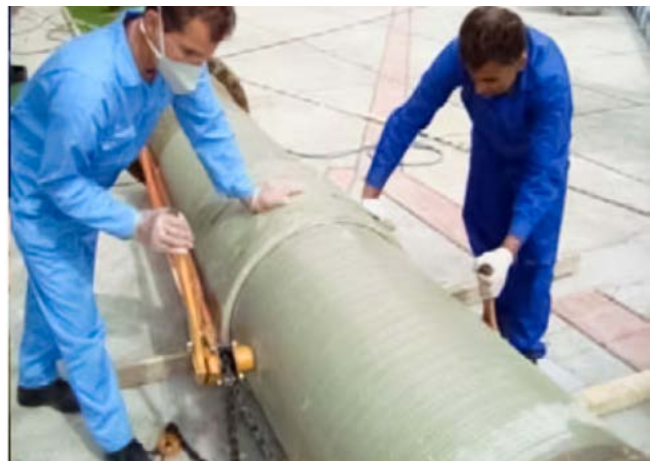
Fig. 4.26 Mufarea cu ajutorul tirforului
