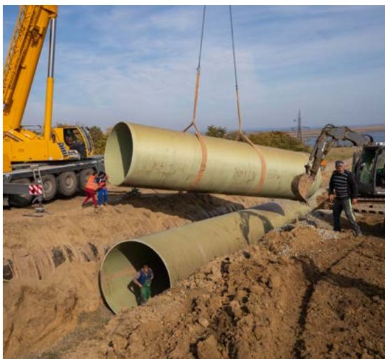
Fig. 3.2: Instalarea subterană standard a unui sistem de conducte uniaxiale de GRP/PAFSIN DN 2800
