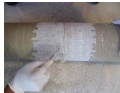
Fig. 4.17 Aplicarea de chit pentru acoperirea golurilor rămase
