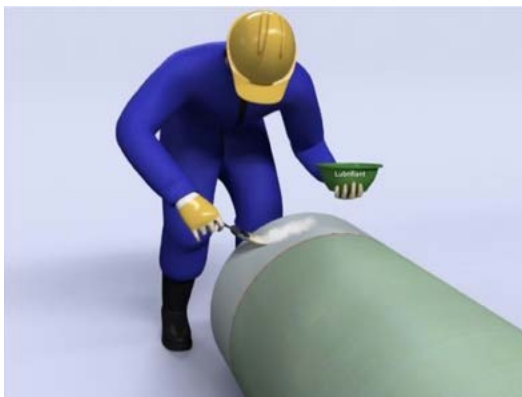
Fig. 4.8 Ungerea cu lubrifiant a capătului de îmbinare al conductei
