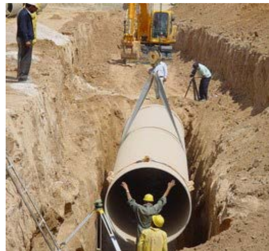
Fig. 3.7 Instalarea unei conducte de diametru mare
