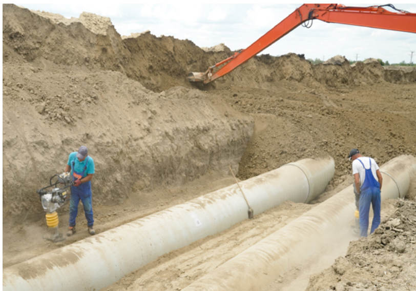
Fig. 3.13 Compactare folosind o placă vibratoare
