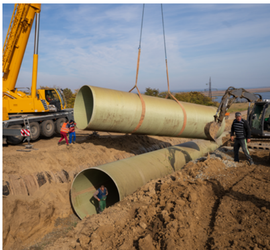
Fig. 3.2: Instalarea subterană standard a unui sistem de conducte uniaxiale de GRP/PAFSIN DN 2800
