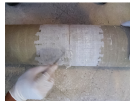
Fig. 4.17 Aplicarea de chit pentru acoperirea golurilor rămase
