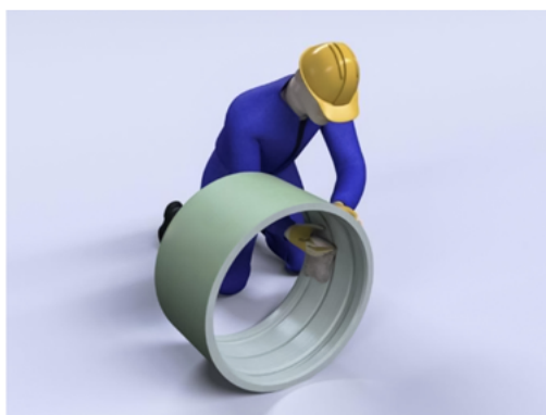
Fig. 4.10 Curățarea nișelor înainte de montarea garniturii
