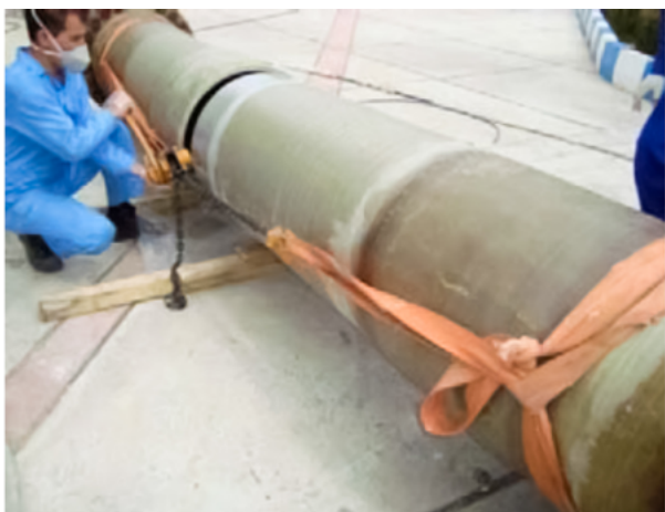
Fig. 4.26 Mufarea cu ajutorul tirforului
