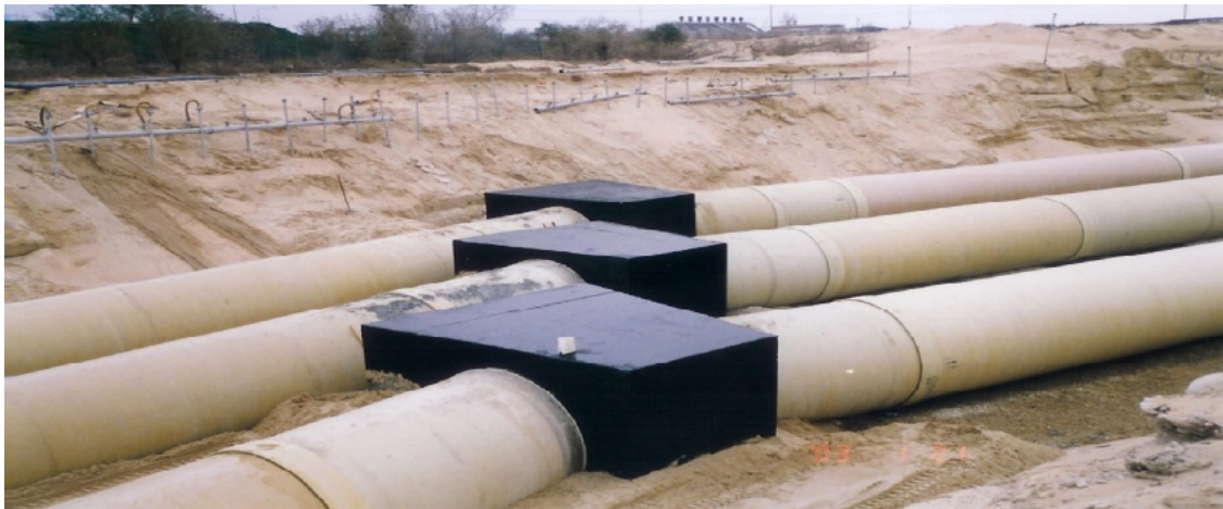
b. Schiță masive de ancoraj pentru cot
