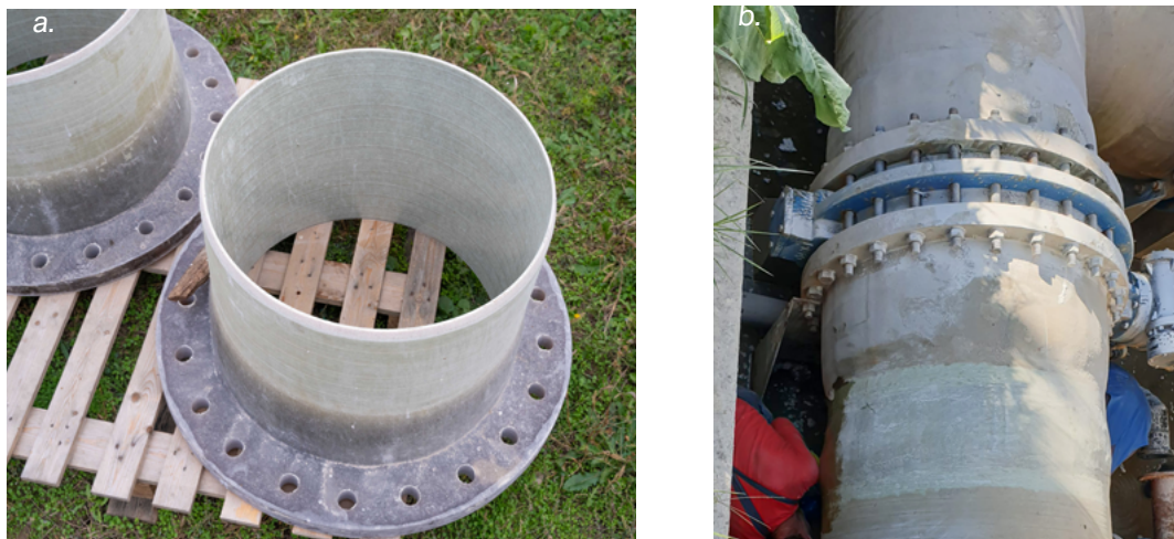
Fig. 4.21 a. Flanșe din PAFSIN, b. Conducte îmbinate cu flanșe din PAFSIN
