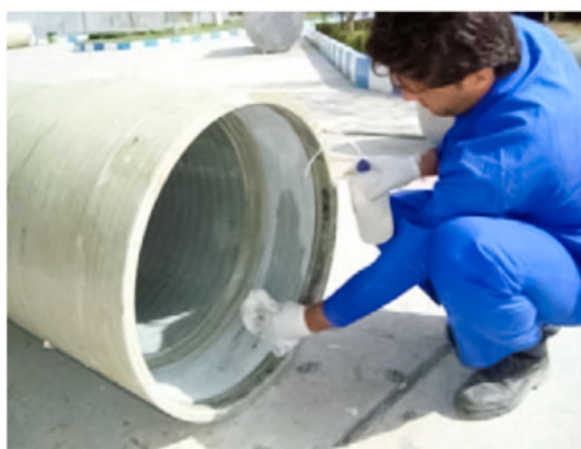
Fig. 4.23 Curățarea zonelor șlefuite și a nișelor mufelor cu o cârpă cu acetonă
