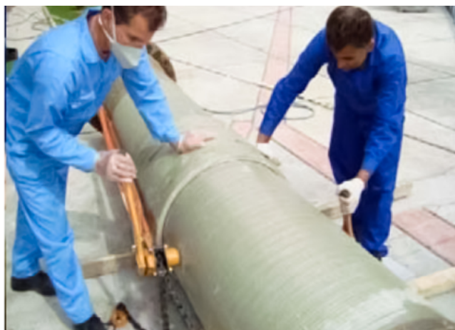
Fig. 4.26 Mufarea cu ajutorul tirforului
