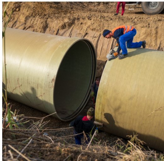
Fig. 3.2: Instalarea subterană standard a unui sistem de conducte uniaxiale de GRP/PAFSIN DN 2800
