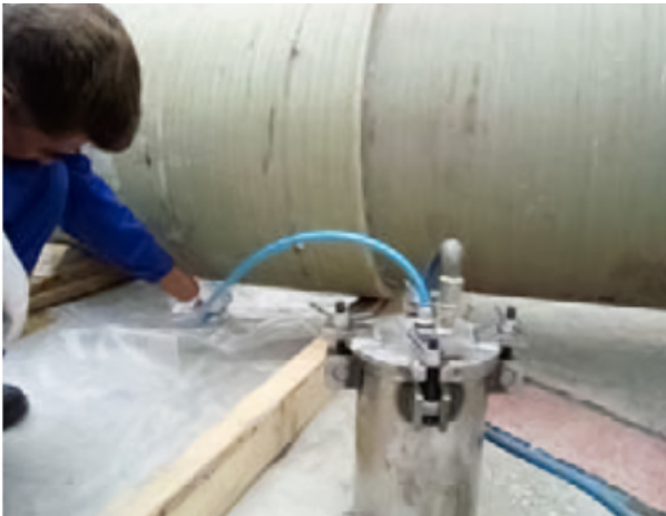
Fig. 4.27 Injectarea adezivului în mufă folosind un compresor de aer
