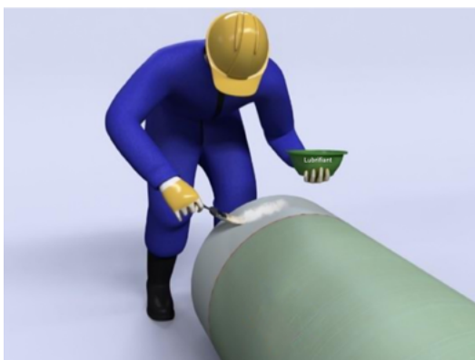
Fig. 4.8 Ungerea cu lubrifiant a capătului de îmbinare al conductei
